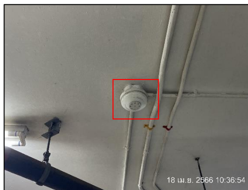
ภาพที่ 15 เครื่องตรวจจับควัน/เครื่องตรวจจับความร้อน
