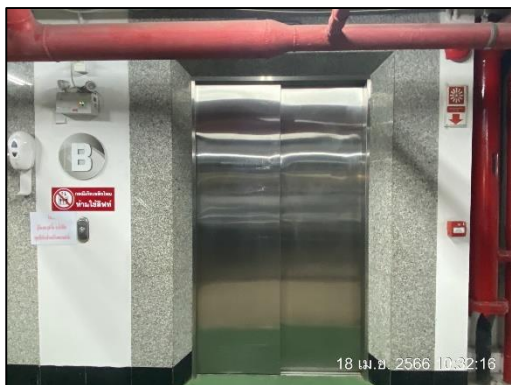
ภาพที่ 11 ลิฟต์ดับเพลิง
