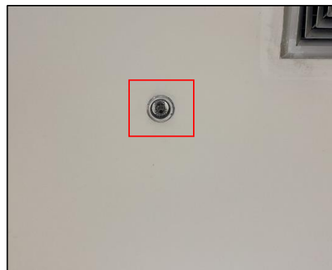
ภาพที่ 12 ระบบหัวกระจายน้ำดับเพลิง
